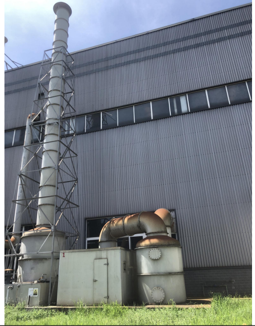
制芯工部制芯废气处理设施“旋风除尘+酸液净化塔”（TA023）+排气筒（DA023）
