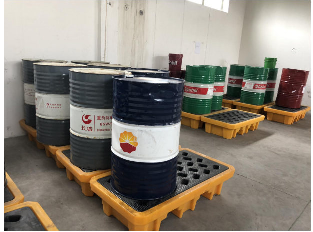
“好圣一期工程”化学品库外部（消防沙、灭火器） “好圣一期工程”化学品库-油品库内部（地面防渗+防渗漏叉车板）
