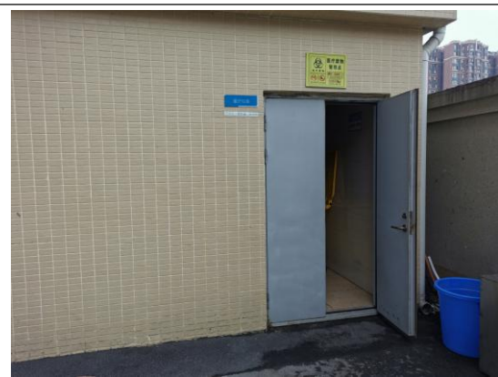
医疗废物暂存间
