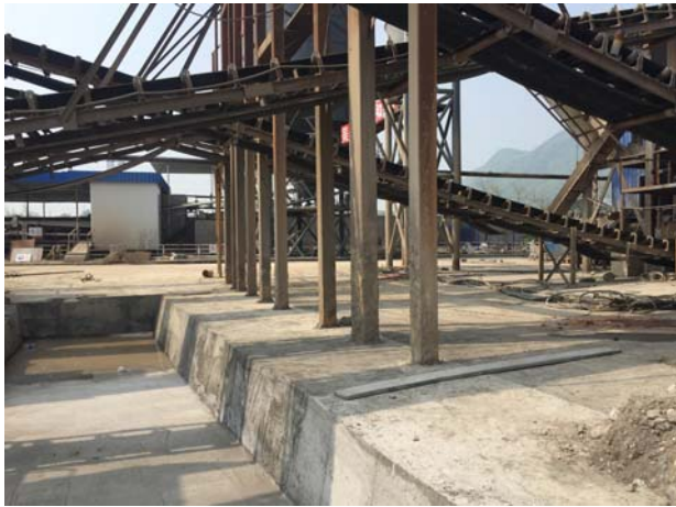
生产区地面硬化、沉淀池
