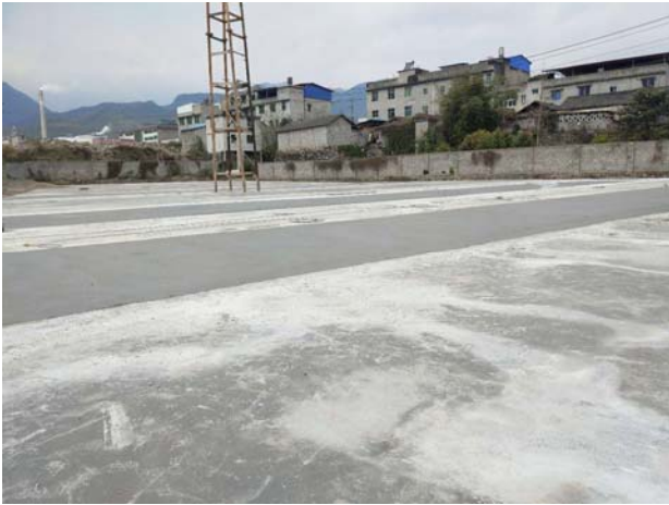
厂区地面硬化处理
